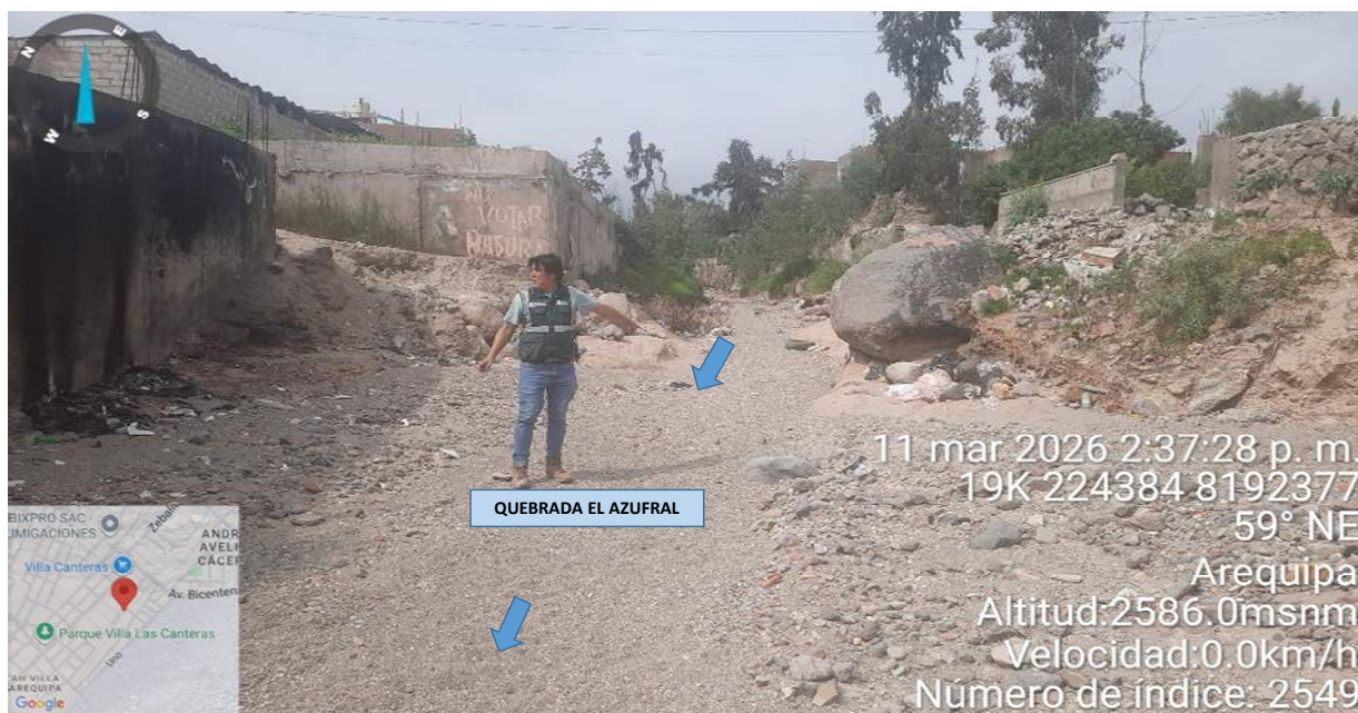
IMAGEN 02: EN ESTE TRAMO SE OBSERVA QUE EN LA MARGEN DERECHA DE LA QUEBRADA EL AZUFRAL, SE ENCUENTRA UN MURO DE CONCRETO, EN MAL ESTADO, Y EN LA MARGEN IZQUIERDA, SUS TALUDES SE ENCUENTRAN DEBILITADOS, SIN PROTECCIÓN Y SU CAUCE SE ENCUENTRA COLMATADO.
